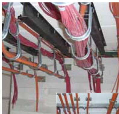
Установка внутри огневой камеры
