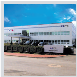
Завод в Даляне (Китай)
